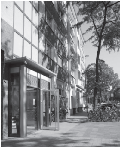
Haus der Wohnungslosenhilfe
